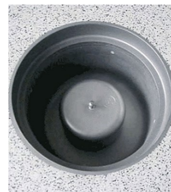
Sigillatura e intervento sullo scarico igienico
